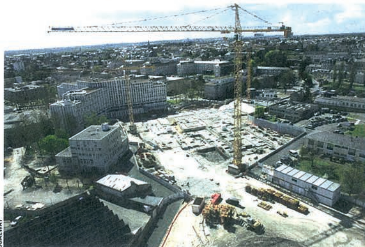
Le chantier du nouveau centre Paul-Papin (20 700 m 2 sur six niveaux) démarre.
