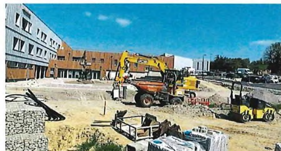
Les extérieurs du lycée sont en cours d'aménagement.
