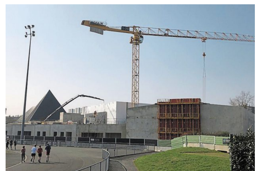
Le chantier du futur gymnase de Monplaisir vu du stade Marcel-Denis.
